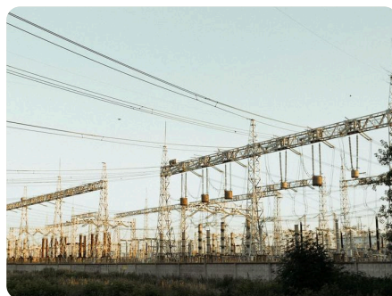
Transformateur de puissance
