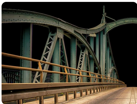
Éléments de charpente métallique
