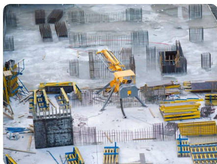
Matériel de chantier MATÉRIEL LÉGER DE CHANTIER
