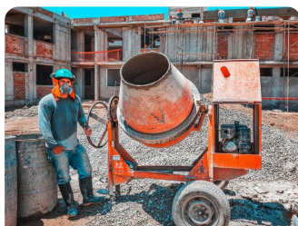
Matériel léger de chantier
