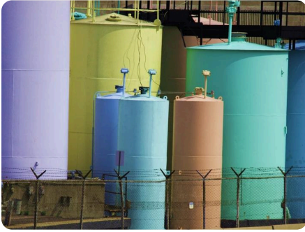
Polietilen su deposu MEKANİK TESİSAT
