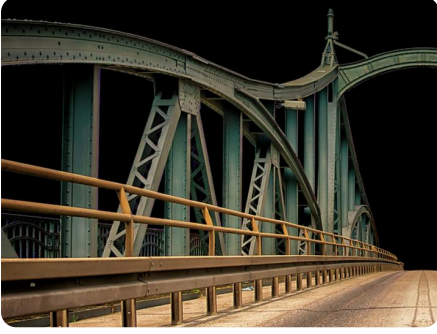
Çelik konstrüksiyon malzemesi
